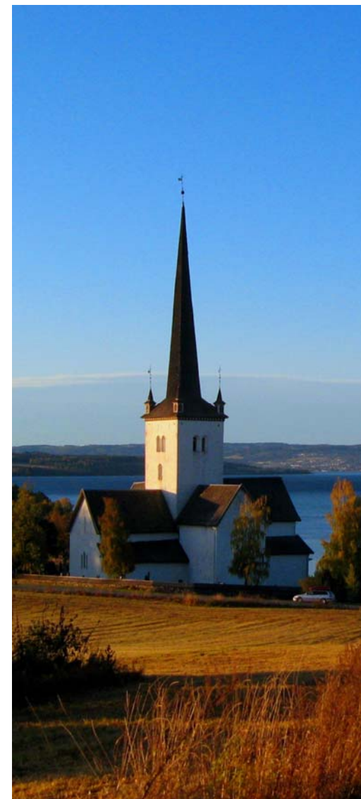
Ringsaker kirke (foto: Ringsaker kommune)
